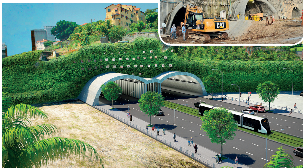
Obras e perspectiva da futura linha carioca de veículos leves sobre trilhos
